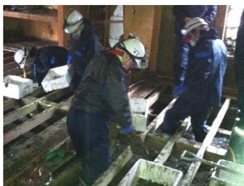
▲床下のヘドロ除去作業へ一致団結
